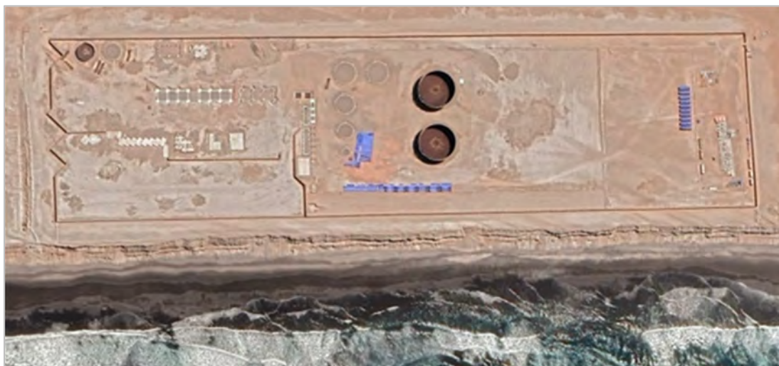
Ilustración 76 Estado actual Proyecto Nuevo Terminal Portuario Multiboyas Ilo (febrero 2023)
