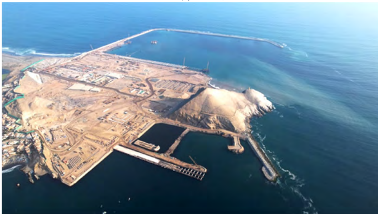
Ilustración 67 Estado actual de Terminal Portuarios de Chancay (finales 2023)
