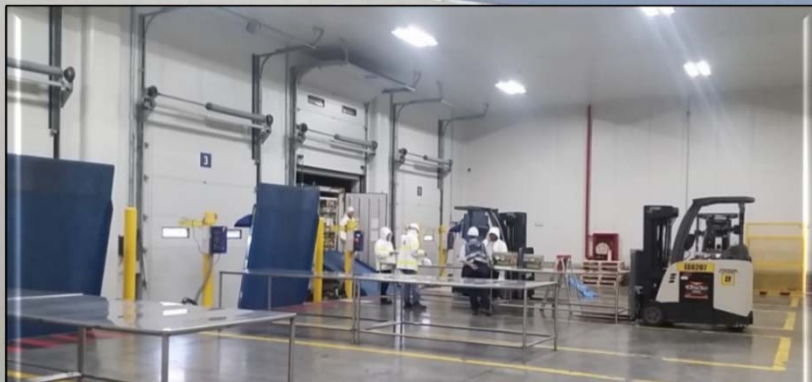
BODEGA DE FRIO SPRB
