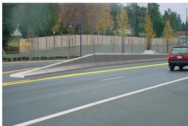
Ilustración 11. Terminal en barrera de seguridad de concreto
